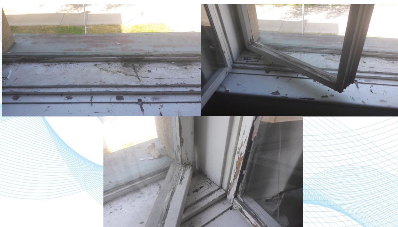
Obrázek 14: Detail stávajících poškozených oken
